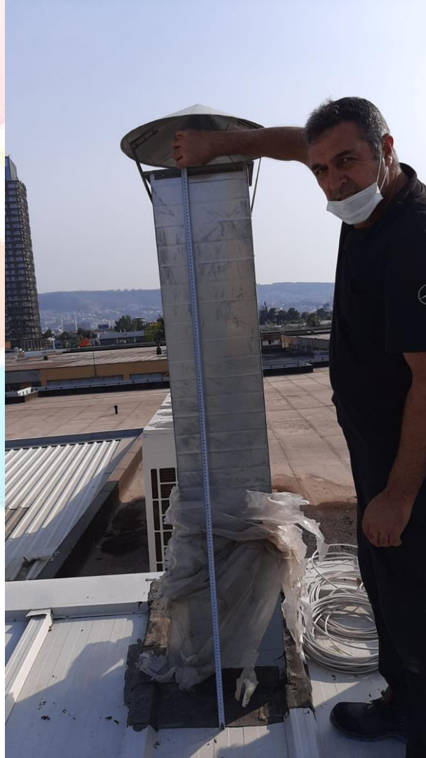
Şekil 2. Baca Analizi İçin Bacanın Boy Ölçümü
