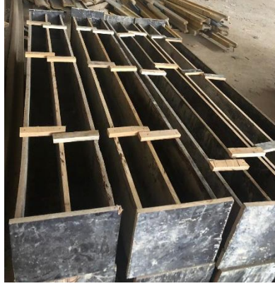
Ahşap kiriş kalıplarının hazırlanması
