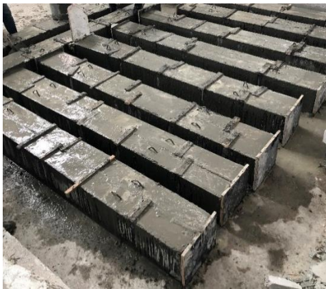
c) Numunelere beton döküm aşaması
