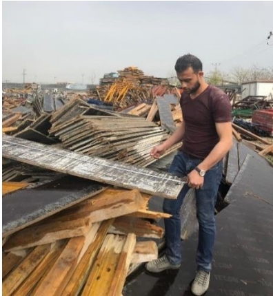
Ahşap kiriş kalıplarının hazırlanması
