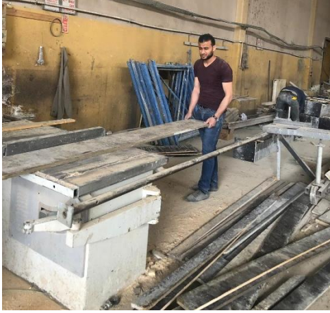
Ahşap kiriş kalıplarının hazırlanması
