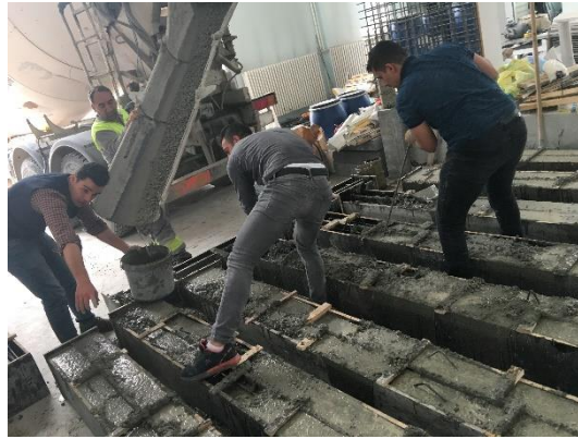
Numunelere beton döküm aşaması
